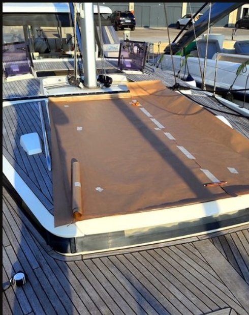
1 · Patrón en cubierta
